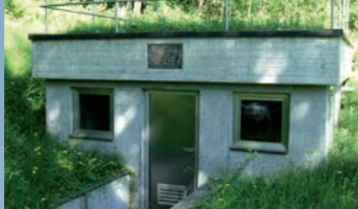
Hochbehälter Stocker 400 m³
